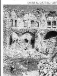
Palácio do Pachá destruído
